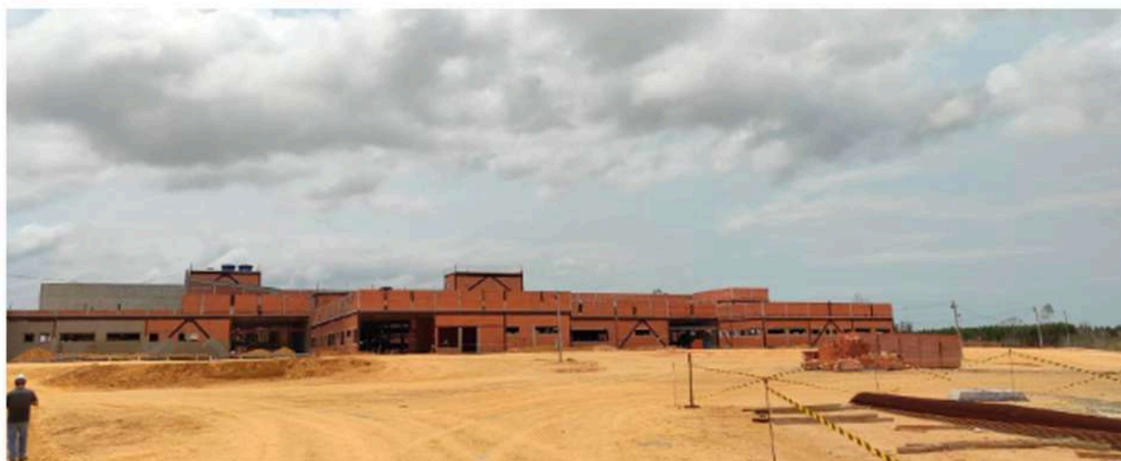
Obra do Hospital em fase de execução de reboco externo
